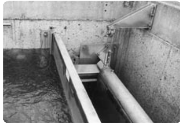
esővíztúlfolyó röviddel a max. duzzasztási cél elérése előtt
