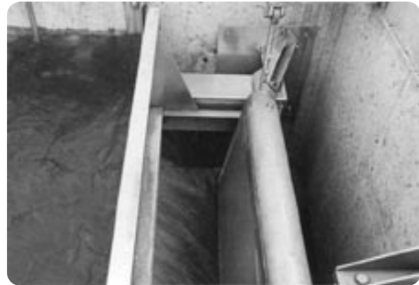
esővíztúlfolyó a max. duzzasztási szint elérésekor (apasztás)
